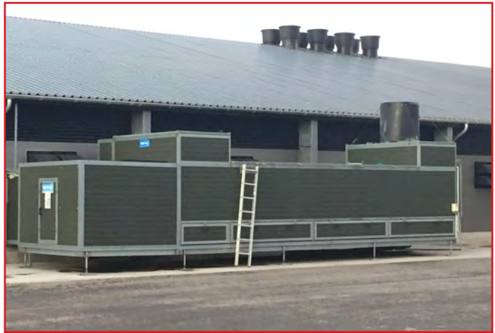
الشكل 6.2: مثال على المبادل الحراري
