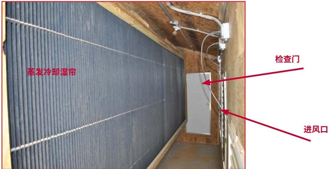
为了使纵向通风系统有效运行，务必根据风机的总排风量适当地算出湿帘面积。
