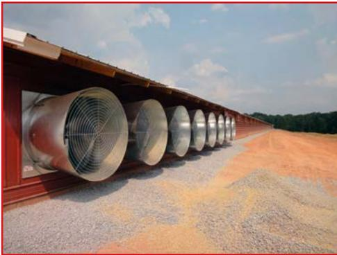
进风口应与纵向风机相对，位于鸡舍的另一端。鸡舍两侧的进风口面积应该相同。纵向通风的进风口通常通过某种铰链门或卷帘系统来关闭。进风口的关闭必须自动并与控制系统相连。
