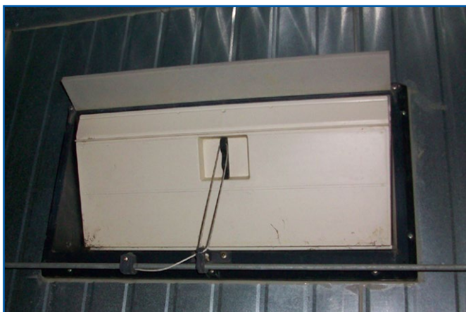
Obrázek 6.9: Příklad kvalitní nasávací klapky.
