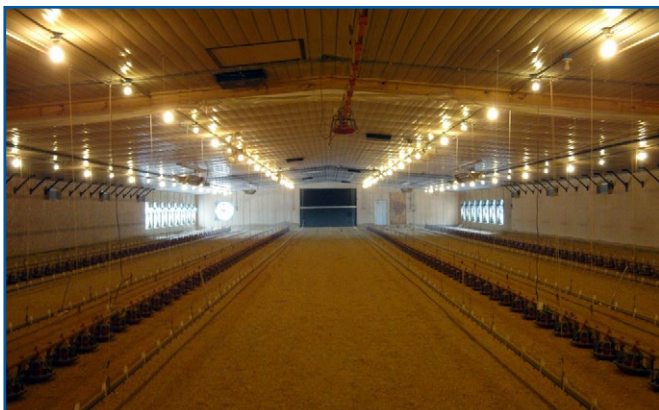
Obrázek 6.3: Příklad haly s nucenou ventilací.
