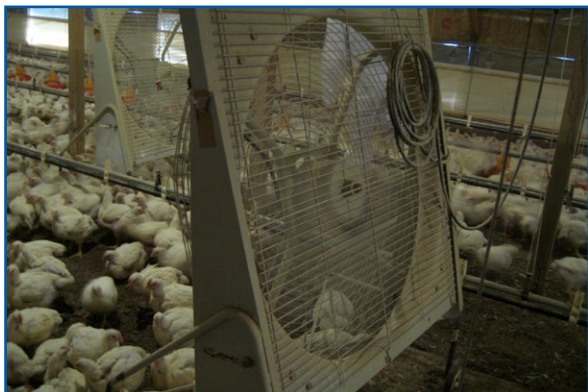
Obrázek 6.2: Cirkulační ventilátory v přirozeně větrané hale.
