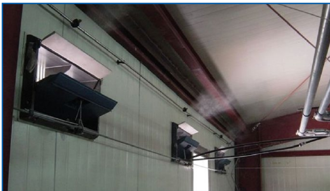
Obrázek 6.21: Příklad zamlžovacího systému v příčně větrané hale
