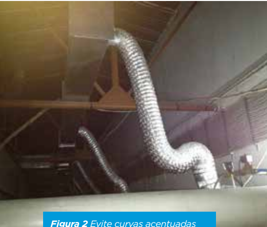
Figura 2 Evite curvas acentuadas em condutas flexíveis.
