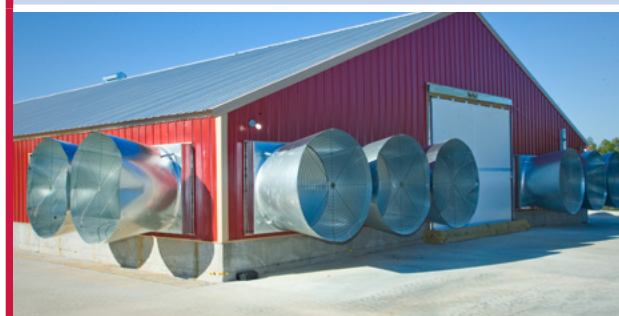
Figura 6.17 Ejemplo de un galpón típico con ventilación por túnel.
