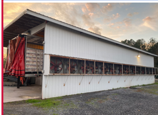
Figura 4.6 Ejemplo de instalaciones de espera adecuadas en la planta de procesamiento.
