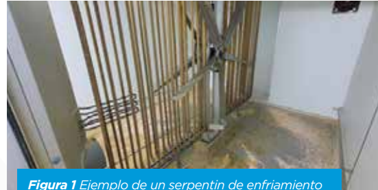
Figura 1 Ejemplo de un serpentín de enfriamiento de la nacedora cubierta con plumón de los pollitos.
