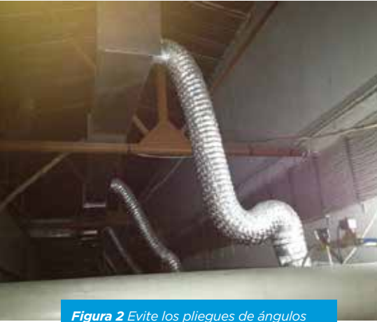
Figura 2 Evite los pliegues de ángulos cerrados en los conductos flexibles.
